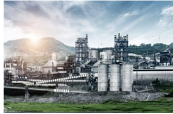
Stavební hmoty přeprava cementu potřebný tlak 4 bar
